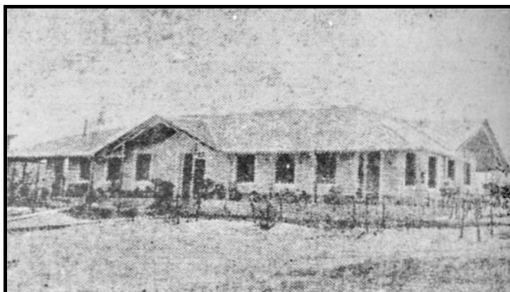
Figura 1 - Hospital de Caridade Jovino Barreto, 1909 (Fonte: Arquivo Geral do Estado).
